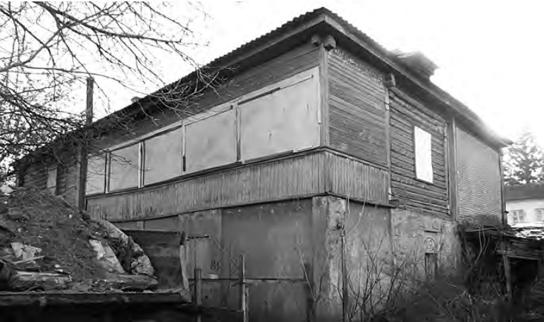
Рис. 4. «Дом жилой» (фасад, выходящий на ул. Гагарина), г. Орел, ул. Гагарина д. 28 дата съемки: октябрь 2013
