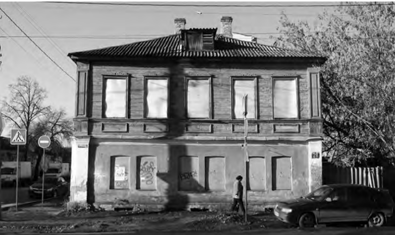
Рис. 3. «Дом жилой» (фасад, выходящий на ул. Гагарина), г. Орел, ул. Гагарина д. 28 дата съемки: октябрь 2013
